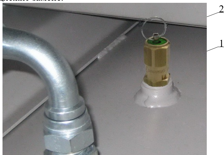
Рисунок 9 – Клапан предохранительный пружинного типа
